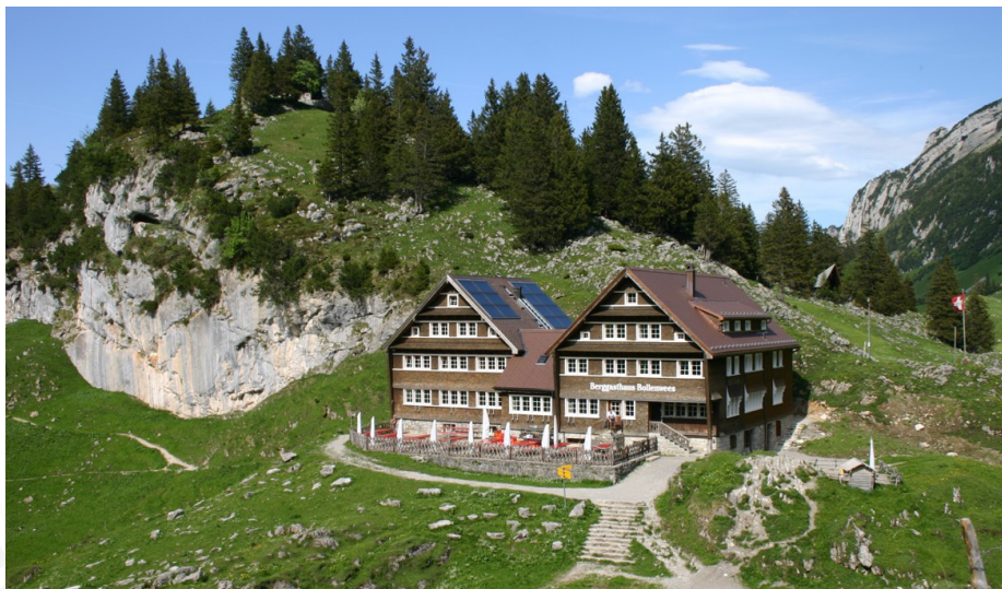
Der Neubau (links) ist vom Stammhaus fast nicht zu unterscheiden. Rechts oben Staubernkanzel, links oben das Clubheim Fälensee Bild Thomas Manser
